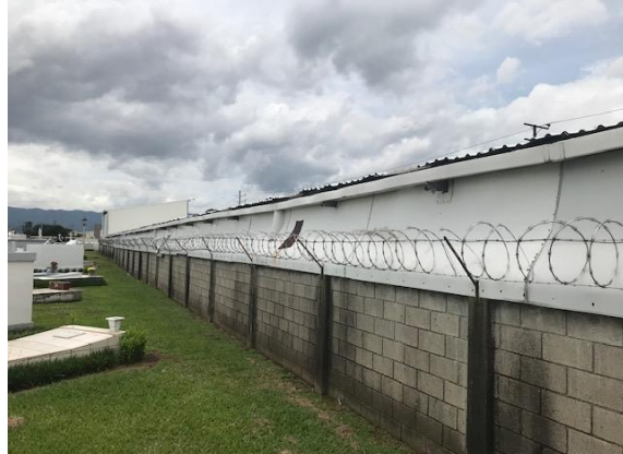
Construcción sobre muros de J.P.S.
