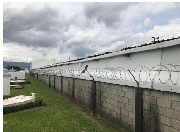
Construcción sobre muros de J.P.S.
